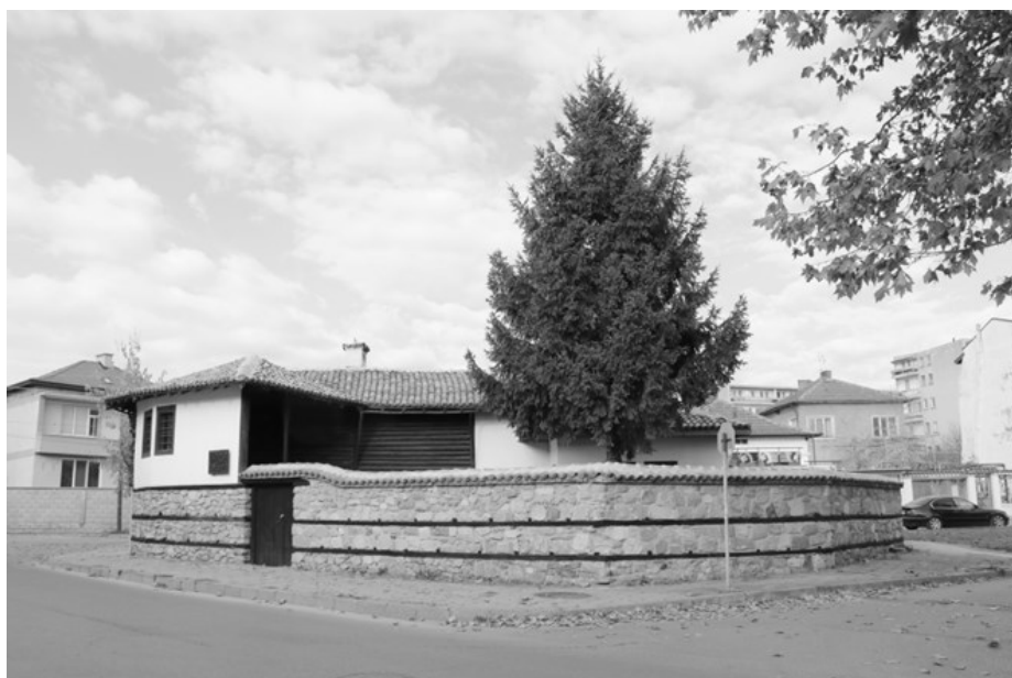
Сградата, предоставена на фотографската общност в Казанлък.
